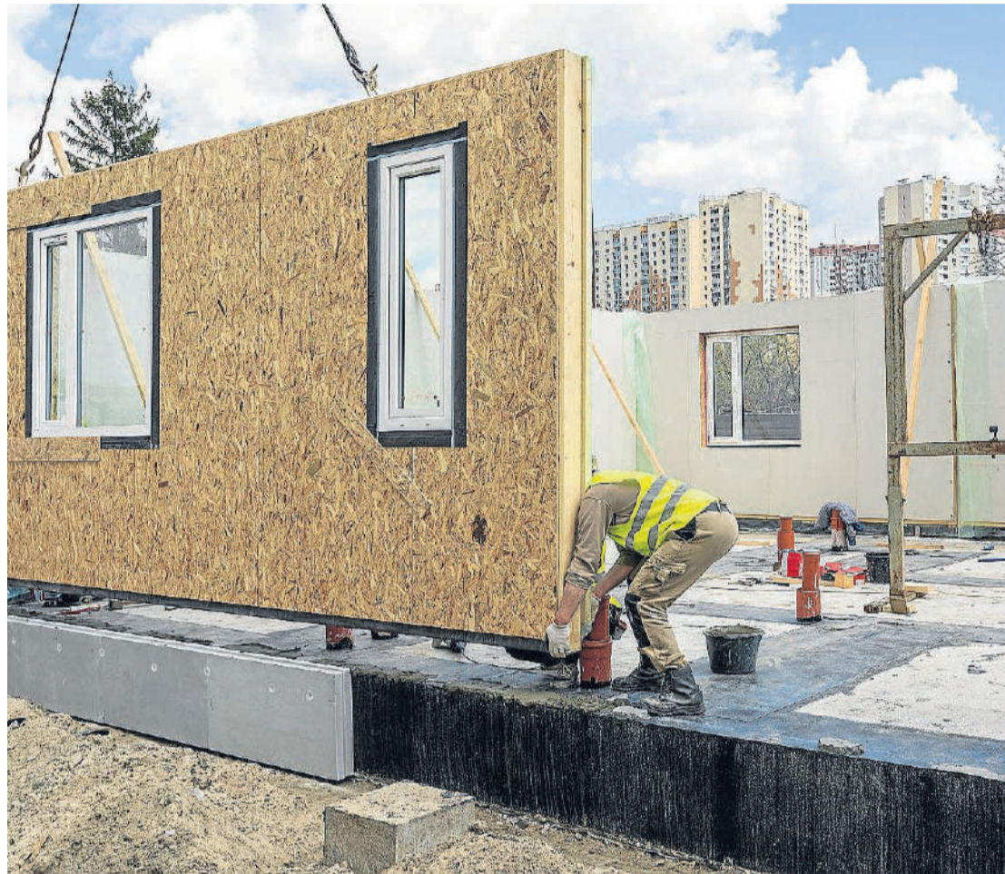
La construcción modular facilita el montaje, desmontaje y reutilización de elementos. LE COLAZ
