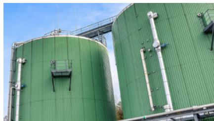
Digestor anaerobio multietapa para depuración de aguas residuales en PYMEs agroalimentarias.
